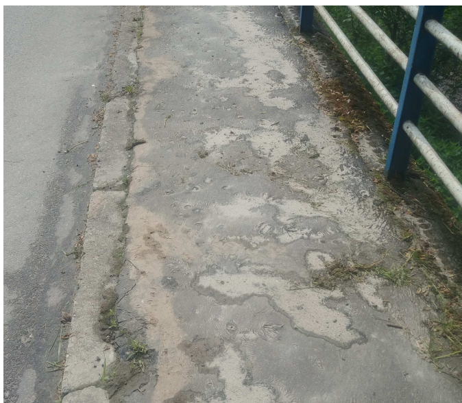
Zdjęcie nr 6: Kapa chodnikowa i krawężnik do demontażu
