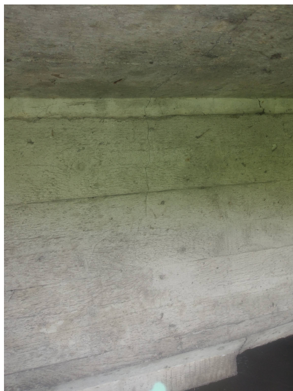
Zdjęcie nr 9: Rysy na płycie ustroju nośnego.
