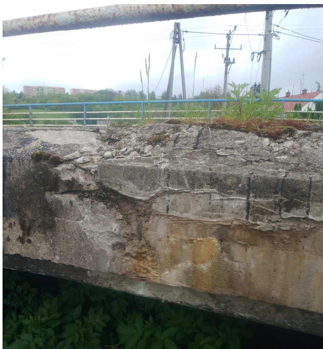
Zdjęcie nr 5: Belka podporęczowa do demontażu
