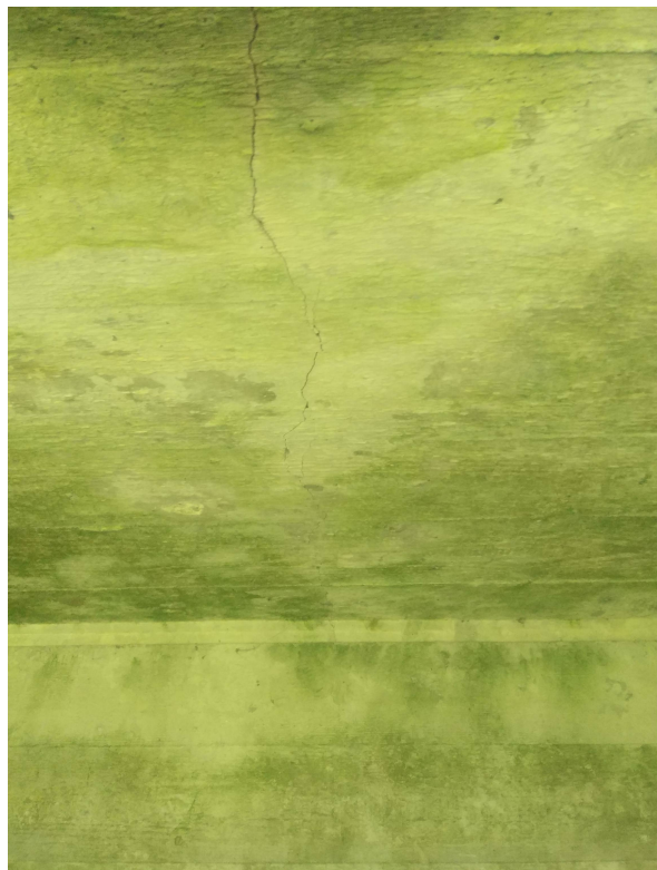
Zdjęcie nr 8: Rysy na wsporniku pomostu.
